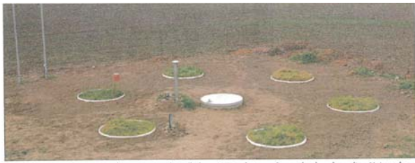
Die Lysimeterstation am Rande von Rustow ist Teil eines 15 Standorte umfassenden bundesweiten Netzwerkes.
